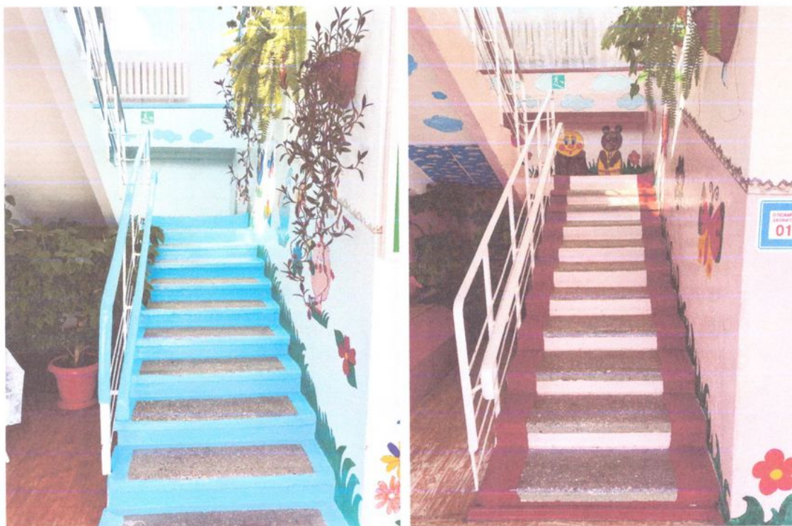
Фото 10. Лестница (внутри здания)
