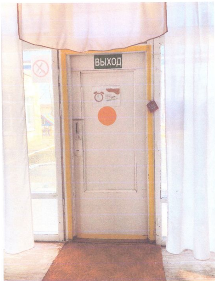
Фото 8. Дверь внутренняя (вход №2)
