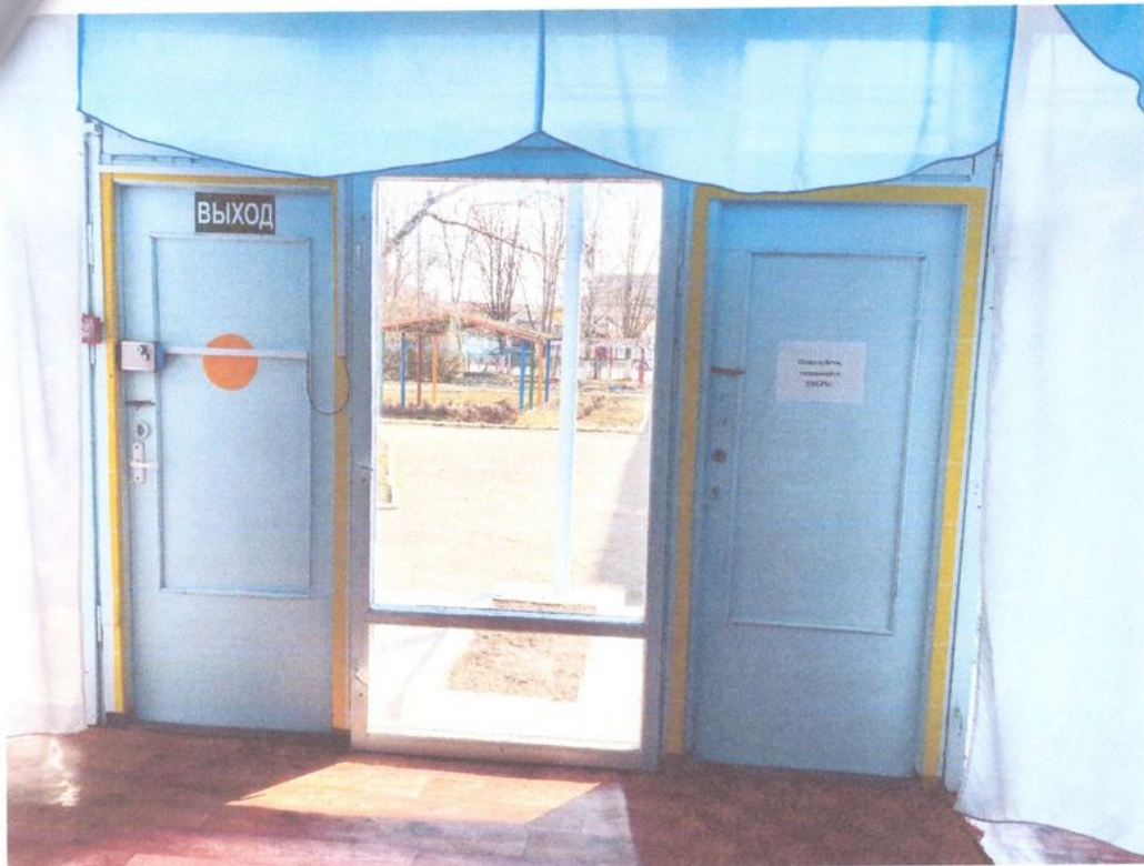
Фото 7. Дверь внутренняя (вход №1)
